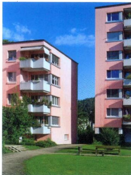
Die Totalsanierung von 128 bewohnten Wohnungen erforderte eine straffe Planung. Die Arbeiten in den Wohnungen wurden strangweise durchgeführt, pro Strang standen vier Wochen zur Verfügung.
