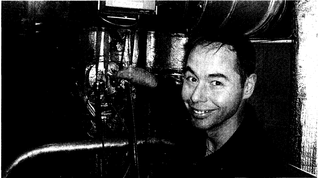
Der Adliswiler Heinz Jenal misst für die Stadt Zürich die Abluft von Grossfeuerungen mit Holzschnitzeln wie jene der Überbauung VistaVerde in Leimbach. Bild: Is.
