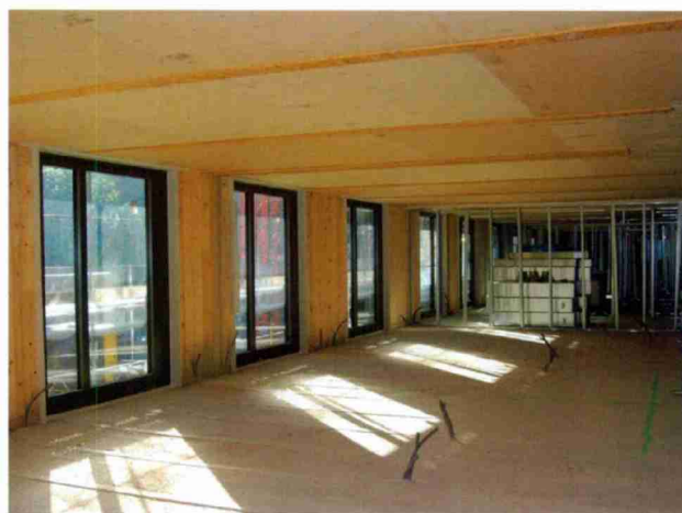
Le gros œuvre terminé, les étages sont divisés en appartements au moyen de parois en construction à sec et de cloisons de doublage avant d'être aménagés. www.knauf.ch
