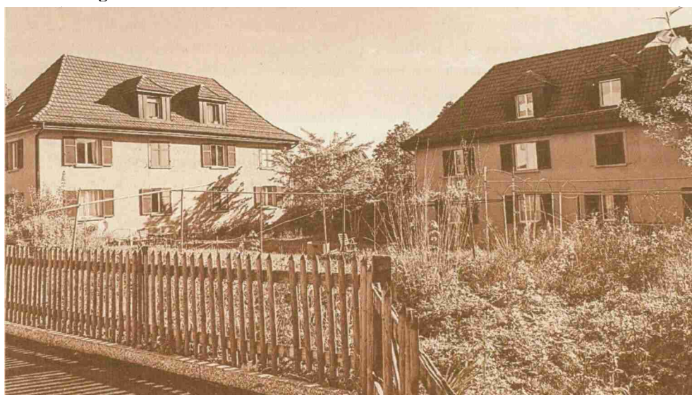
Die beiden südlichsten Häuser der fast hundertjährigen Breiteli-Siedlung sollen neuen Genossenschaftswohnungen weichen. Arthur Schächpi
